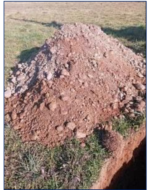
Scavo della trincea T2
