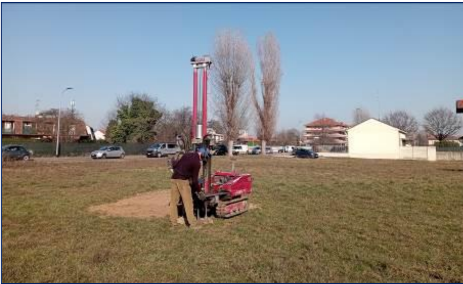
Prova P2 in corrispondenza della trincea T2
