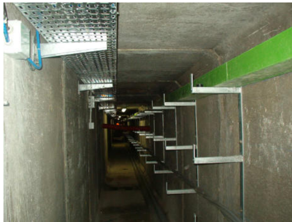
Cunicolo tecnologico in fase di approntamento in altro comune
