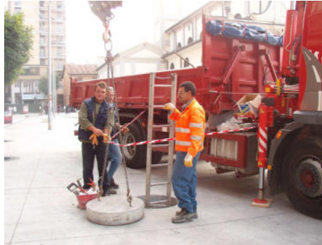
Ispezione di una galleria tecnologica in altro comune
