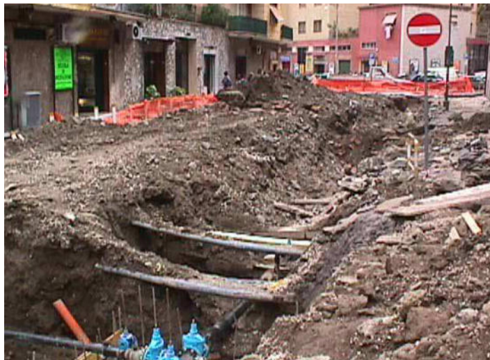
Esempio di cantiere per intervento infrastrutture del sottosuolo
