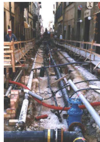
Interventi di infrastrutturazione dei sottoservizi in ambiente urbano
