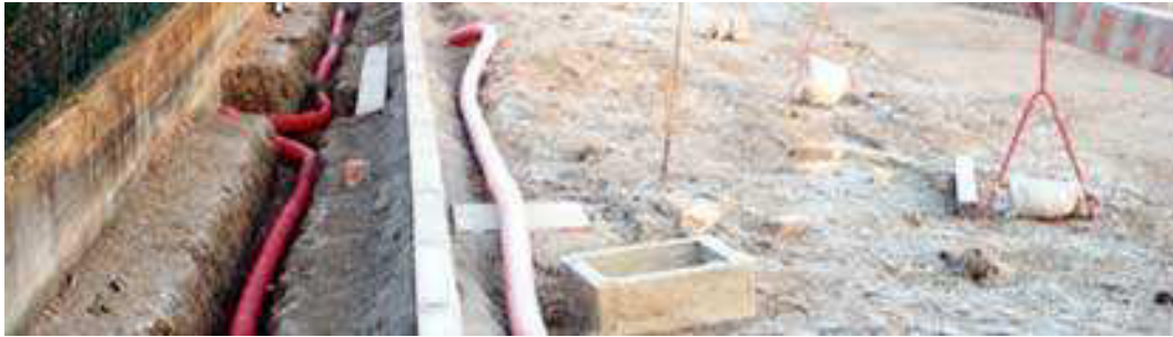
Posa di reti a fibra ottica nel sottosuolo stradale
