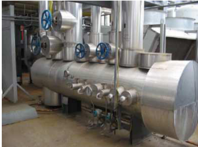
Collettore vapore 21 bar
