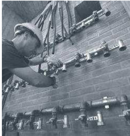
Rubinetti gas predisposti per allaccio contatori.
