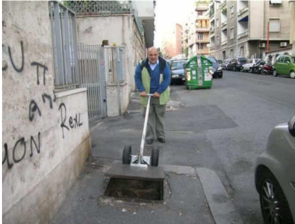
Operatore in azione per l'apertura chiusini con strumento dedicato
