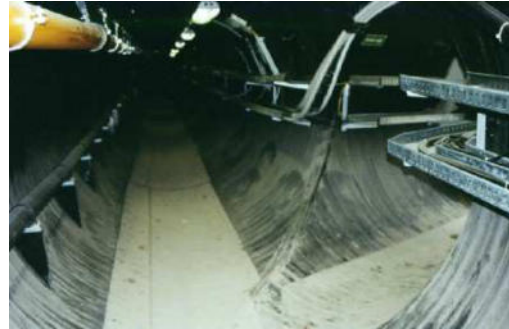
Esempi di canali (200 cm) dato Web
